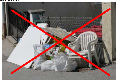
Exemple de mauvaise pratique : plus de 1 m 3 , matériaux de rénovation et déposés trop tôt
