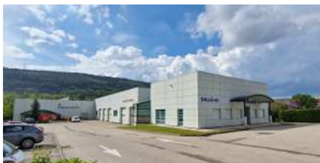
Complexe du Lange : services techniques, salle Est, caserne des pompiers et gymnase
